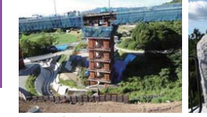
大切畑大橋のジャッキアップ状況
