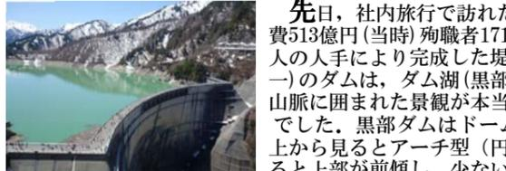
先日、社内旅行で訪れた黒部ダム。総工費513億円(当時)殉職者171名、延べ1000万人の人手により完成した堤体高186m(日本一)のダムは、ダム湖(黒部湖)や3000m級の山脈に囲まれた景観が本当に美しく感動的でした。黒部ダムはドーム型アーチダムで、上から見るとアーチ型(円弧)、横から見ると上部が前傾し、少ないコンクリートで荷重を支持する構造となっている。また、地形の関係で両端の支持岩盤が確保できず、ウイング(重力式)で補強しているため、両端が「くの字」となっている。黒部ダムの放水は観光放水であり、発電に使う水は取水口から10km離れた地下発電所に流れる。周辺の地形、地質等も含め見処の多いダムでした。K/S
