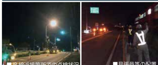
■JR線近接箇所での点検状況
