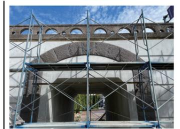
小国町の宮原地区。旧国道宮原線に架かっていた橋が老朽化により、写真に示す跨線橋に変わりました。往時の国鉄トンネルをイメージした坑門(エントランス)はアーチ状の石張模様。その内側を2mのBoxカルバートで歩行者を安全に通す施設です。近年、宮原線の終着駅があつた所は、ユーステーションになっており地元や近隣の来訪者が当地を訪れています。h/n
