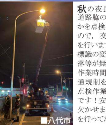
秋の夜長、道路附属物点検の仕事で、道路脇の照明・標識に損傷や異常が無いかを点検しています。道路規制を伴いますので、交通量が多い道路等は夜間に点検を行います。点検では柱の腐食や変形等、標識の変形や取付部のゆるみ・ボルトの脱落等が無いかを調べます。1箇所当たりの作業時間は1時間程度なので、次々と交通規制を繰り返しながら進めていきます。点検作業と交通安全管理が重要なポイントです!安全に進めるためにチームワークは欠かせません。毎日しっかりとミーティングを行ってから作業を開始します。k/t
