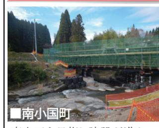
令和2年度に設計した道路及び橋梁の建設工事が南小国町満願寺で進んでいます。本橋梁は、砂防河川小田川を渡る橋長29.5m、標準有効幅員8.3mのPCポストテンション方式単純中空床版橋です。下部工は令和4年度完了を目指し建設が進んでいます。橋梁架設が完了すると道路規格第3種第4級の道路建設がスタートします。n/s
