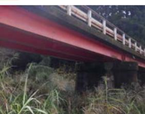
プレートガーダー橋(桁橋)は、左写真のように鋼材を主桁に用いた橋で、鋼板をI型に溶接したものやH形鋼が使用されています。中小規模の橋梁で見られるこの形式は、設計・製作が容易で、構造が簡素で軽量なため現地工事が容易であり、下部工を小型化できる等の特徴があります。鋼材は耐候性鋼材を除き定期的に塗装が必要ですが、点検において初期不良を発見しやすい、ほぼ100%のリサイクルが可能などメリットがあります。しかし、近年は経済性の面からPC橋が主流となっているようです。K/S
