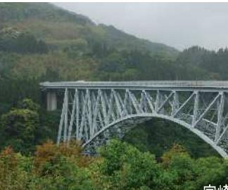
宮崎北部、日之影町で、建設当時東洋一の高さを誇った青雲橋を見てきました。本橋はスパンドレルブリースドアーチ橋で、橋長410m、水面からの高さは137mで、建設に10年の歳月を費やして完成しました。このような巨大な橋梁は部材を単純に組上げれば完成するわけではなく、各部材の制作誤差や現場の組立誤差を考慮し、アーチ部に支柱や斜材を組み、桁や路面が載る過程で自重によりたわみが発生し、架設設備の引き込み量や鋼部材は日々の温度変化により伸縮するため、それらを考慮し完成に至るそうです。K/S
