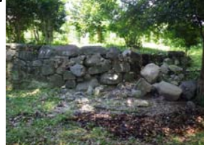
石垣被災直後写真
