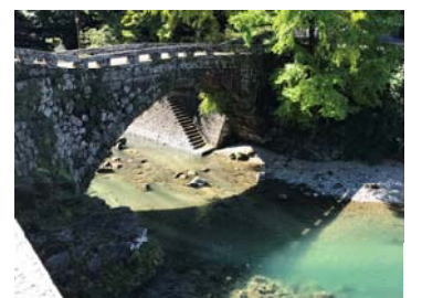
完成した二俣福良渡から見える♥の橋
