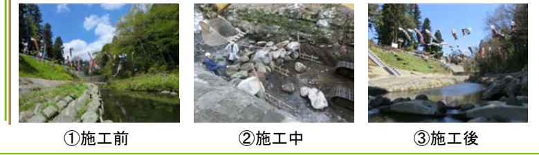
①施工前 ②施工中 ③施工後
